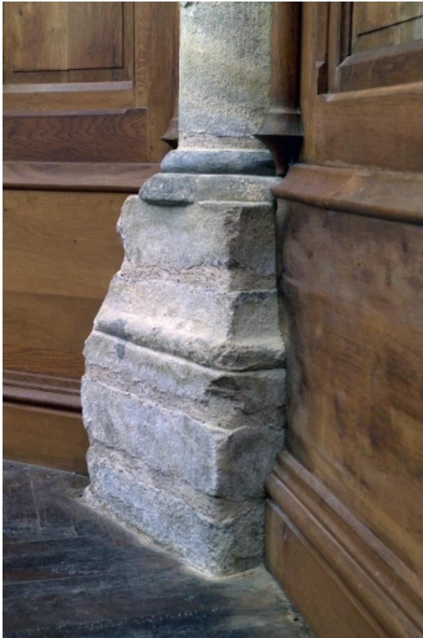
Détail d'une base de colonne du chœur.
