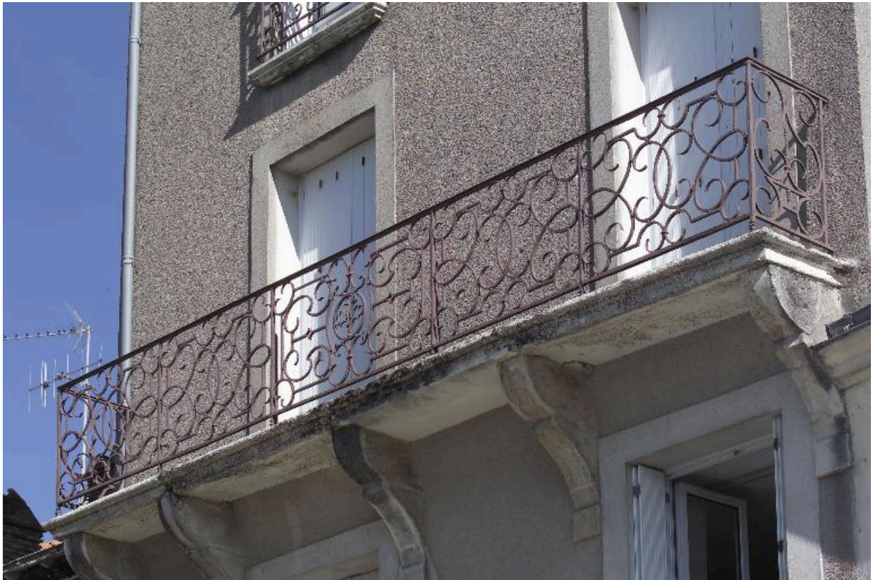
La façade sur la rue, le balcon filant du deuxième étage.
