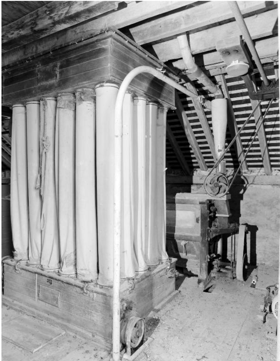
Etage en surcroît, partie nord-ouest, en 2002 : le filtre à air de la marque Ph. Lafon ; au second plan, la bluterie à son.
