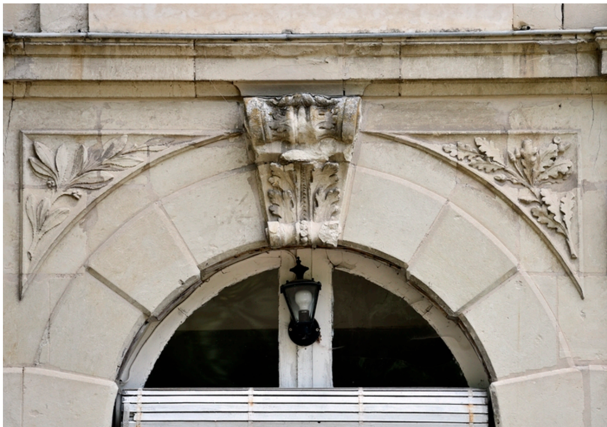
Détails de l'agrafe de la porte ouest du pavillon sud-ouest.
