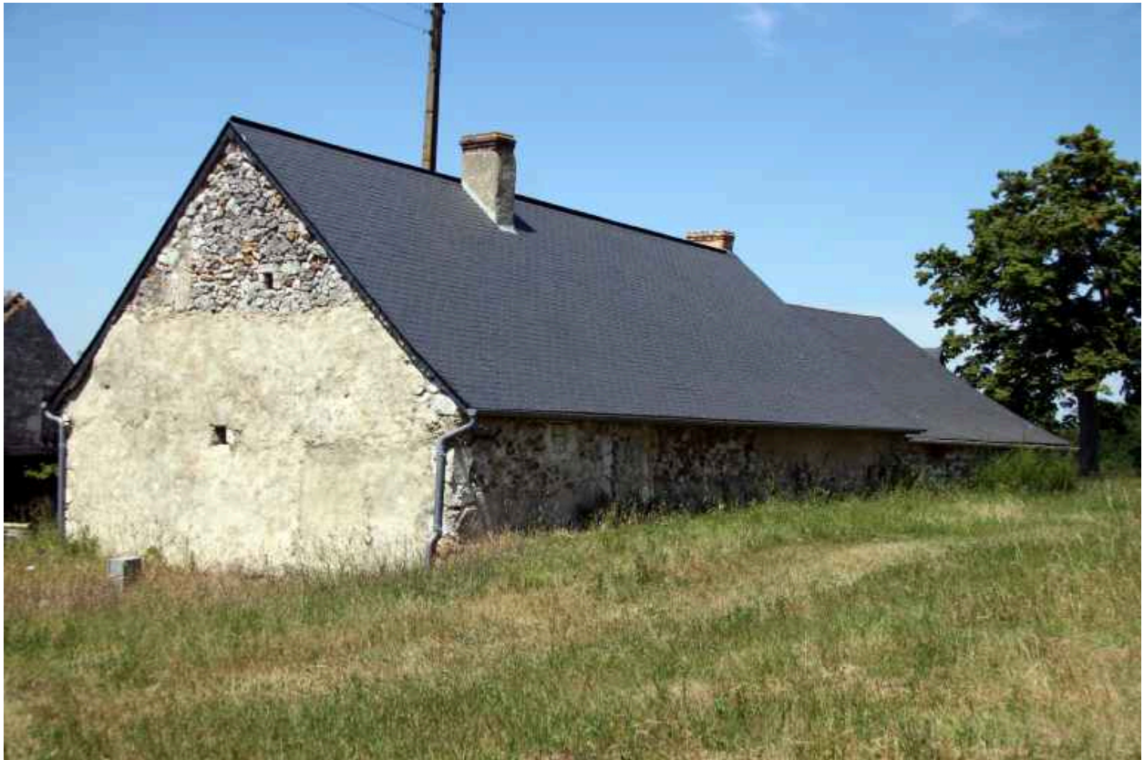
Maison d'habitation, façade postérieure.
