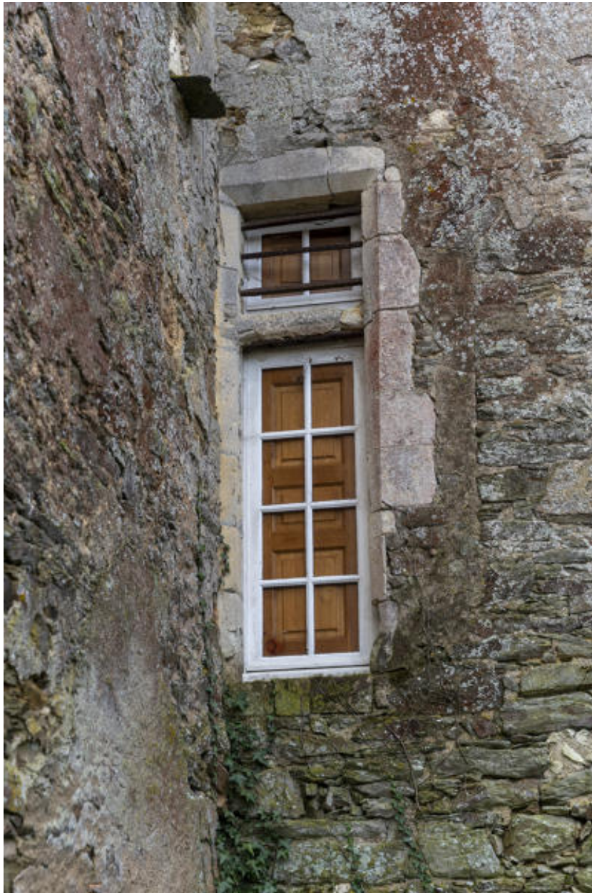
Une demi-croisée de la façade postérieure.
