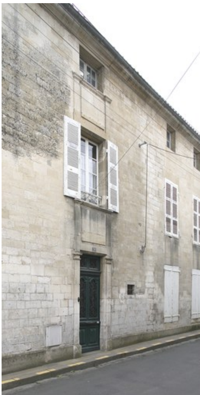
Vue partielle de la façade sur rue.
