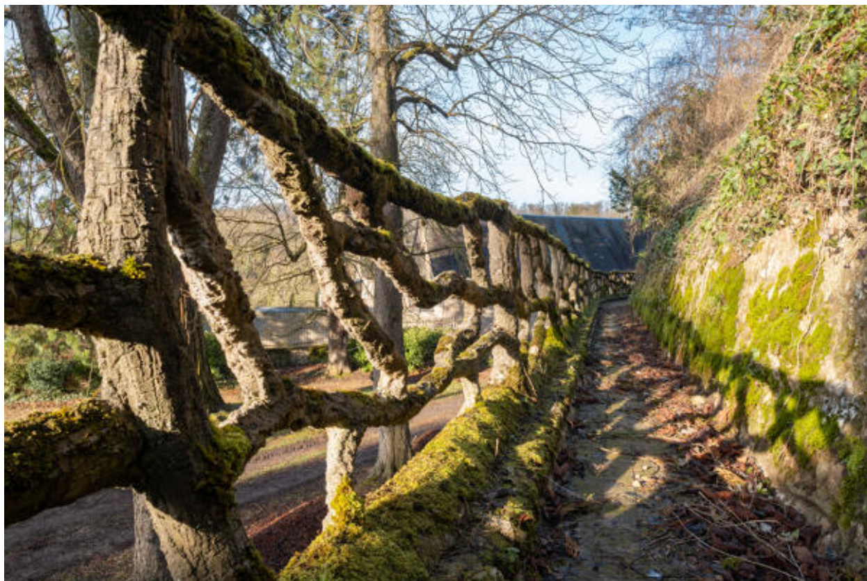
Garde-corps en béton rustiqué.
