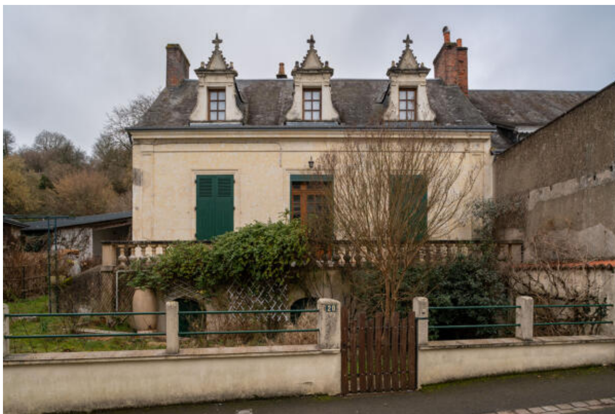
Maison avec façade en pierres de taille calcaires, 20 rue Neuve.
