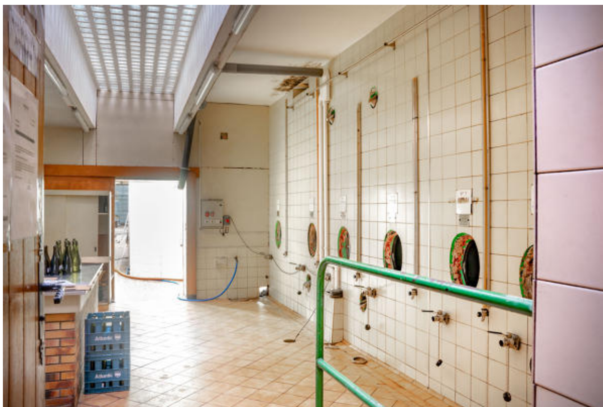
Cuves aériennes, nord-est.
