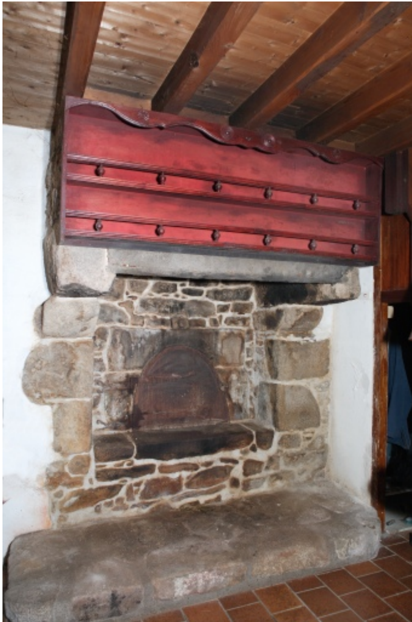
Détail de la cheminée du logis est.
