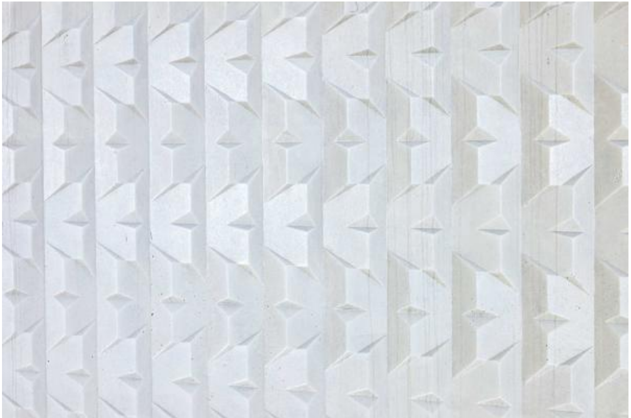
Moulurations sur panneau béton intérieur de l'église.
