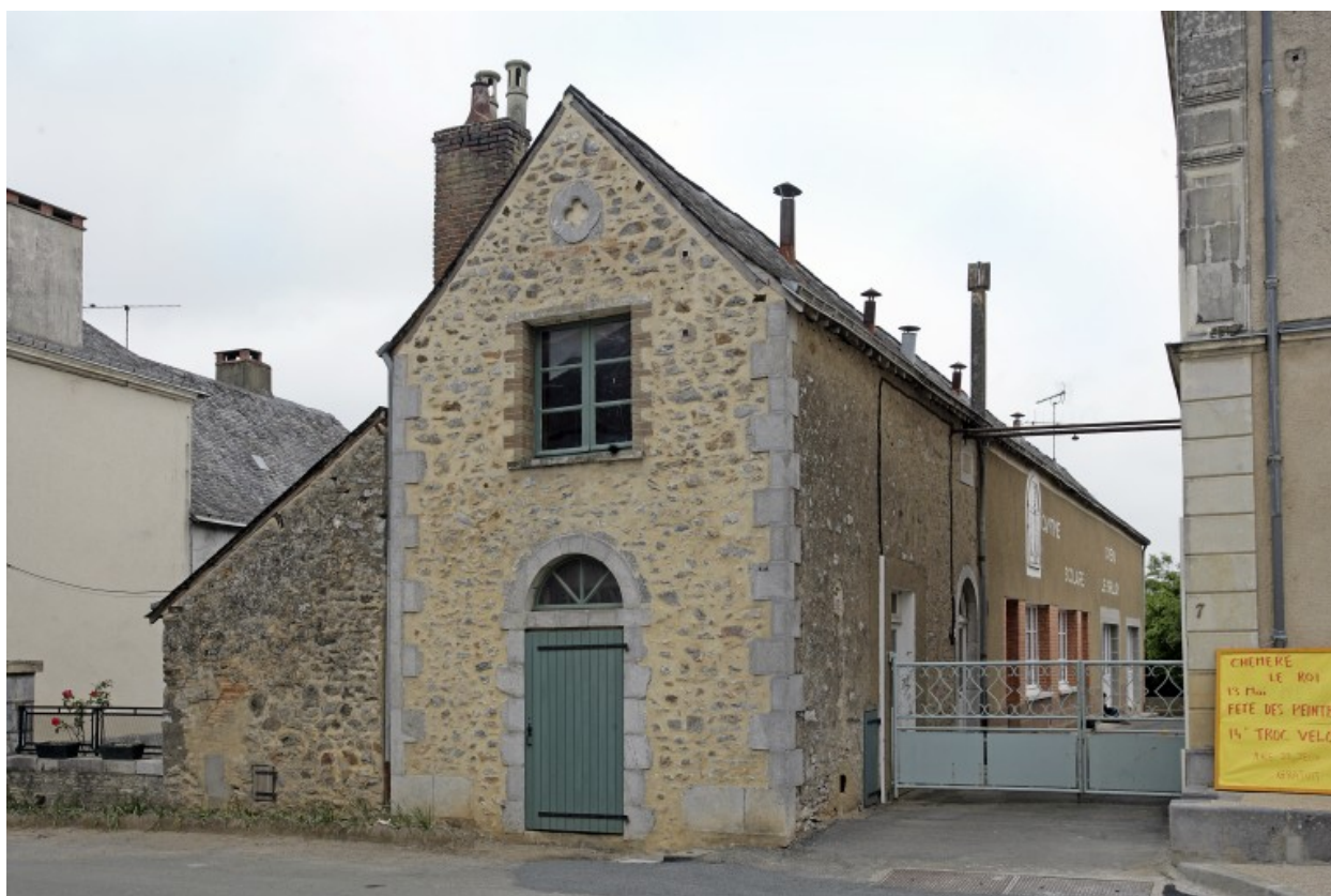
Vue depuis la rue au sud-ouest.
