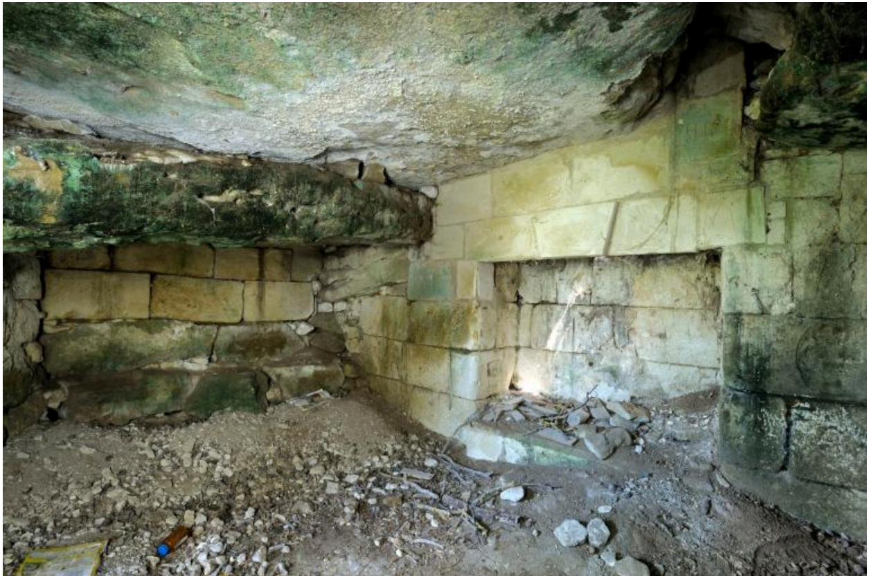
Aménagements du XIXe siècle (cheminée, murs) sous les dalles effondrées du dolmen.
