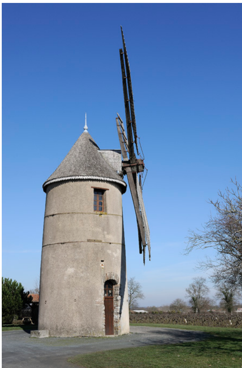
Le moulin Guillou, façade sud-ouest.
