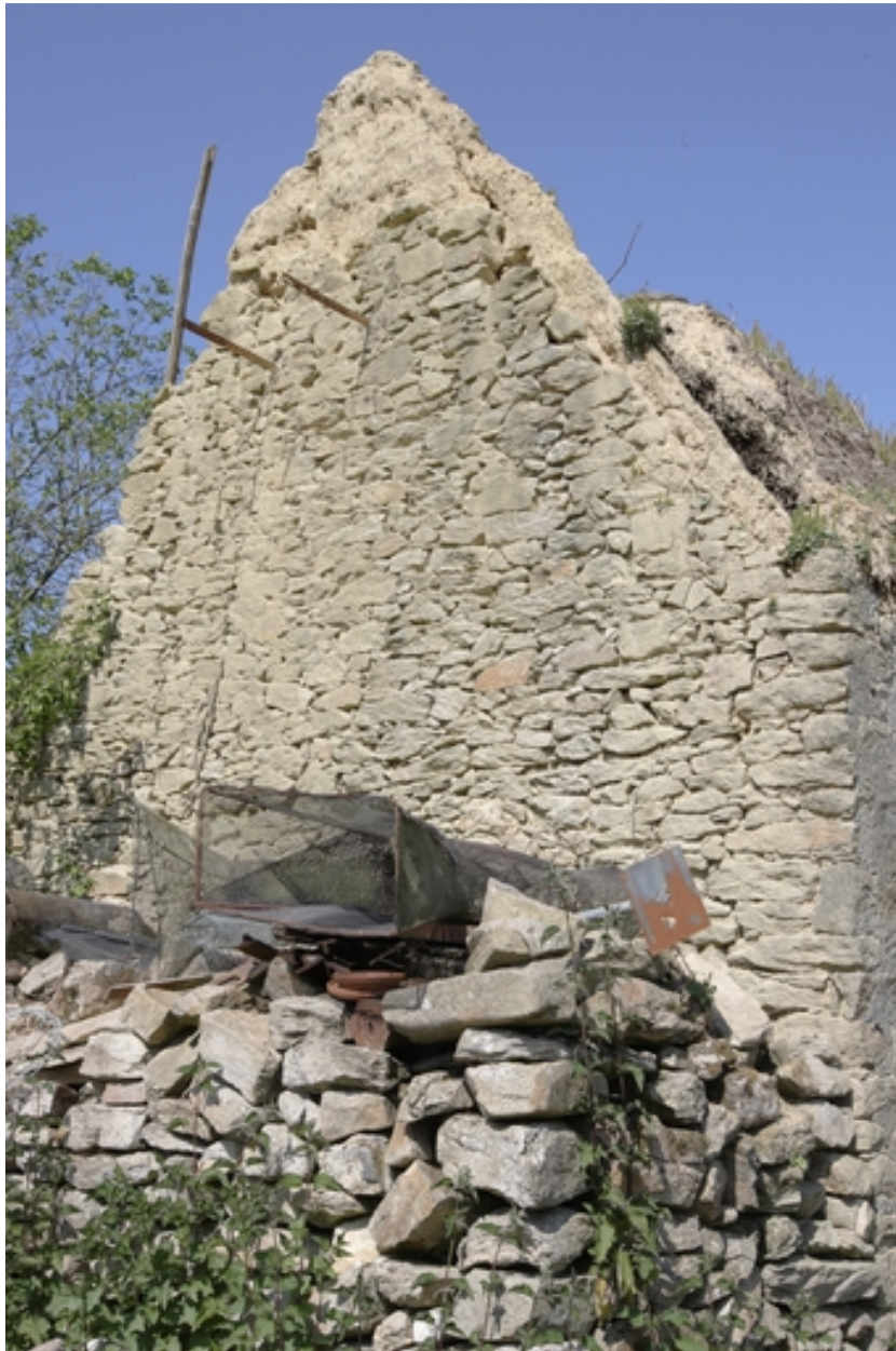
Vue du pignon oriental en bauge.
