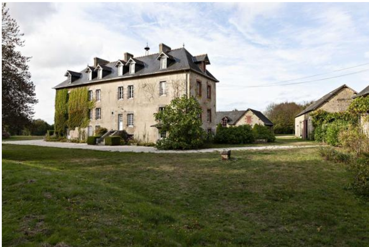
Maison de la Guette, depuis le sud-est.
