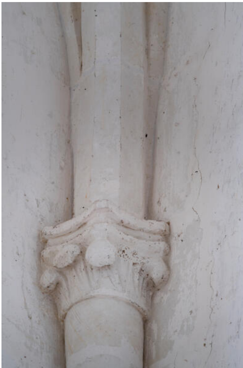
Chapiteau postérieur droit de la chapelle sud.
