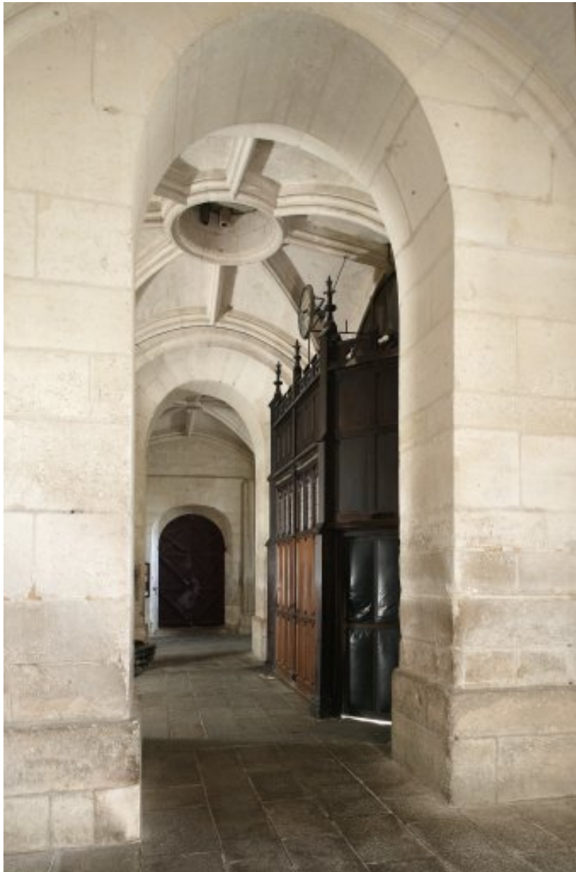
Vue d'ensemble du rez-de-chaussée du massif occidental, prise de la travée nord.
