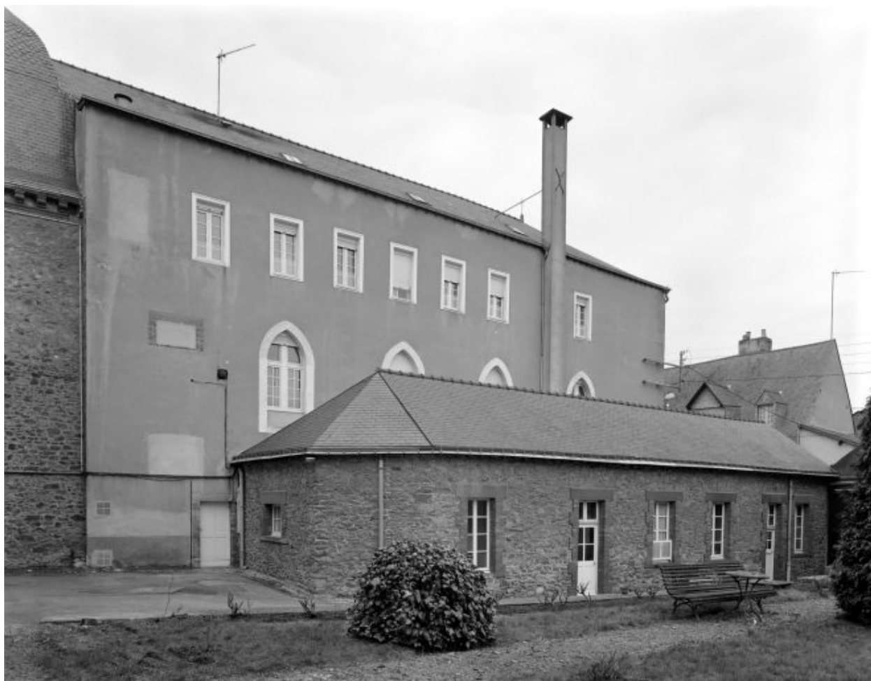
Première cour latérale nord : élévation nord de l'ancienne chapelle.
