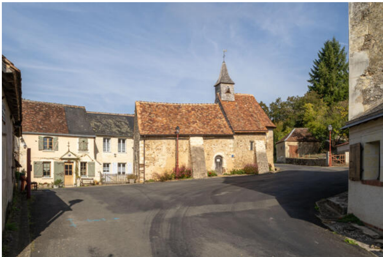
Le carrefour central, vu depuis le sud-est.
