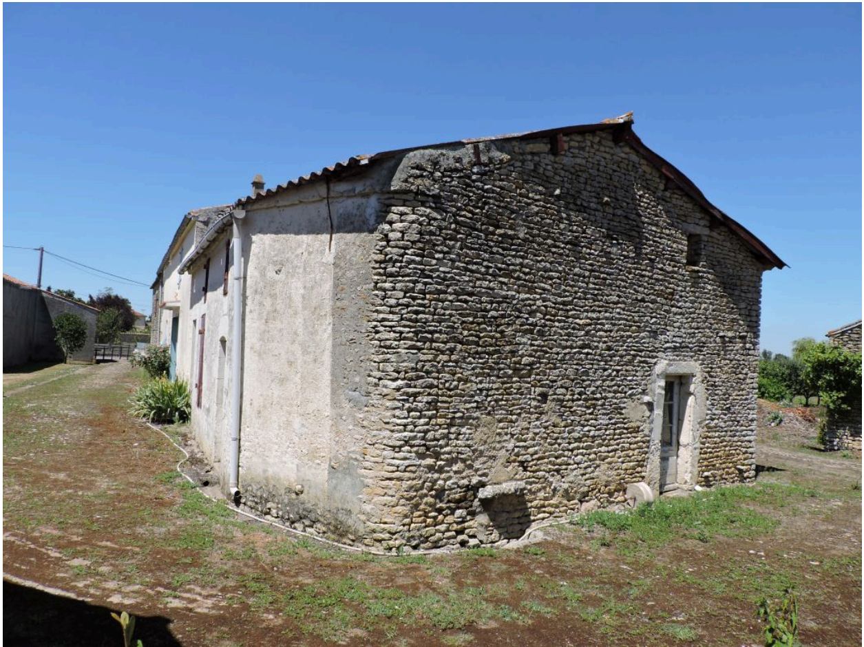
Le logis vu depuis le sud-est.
