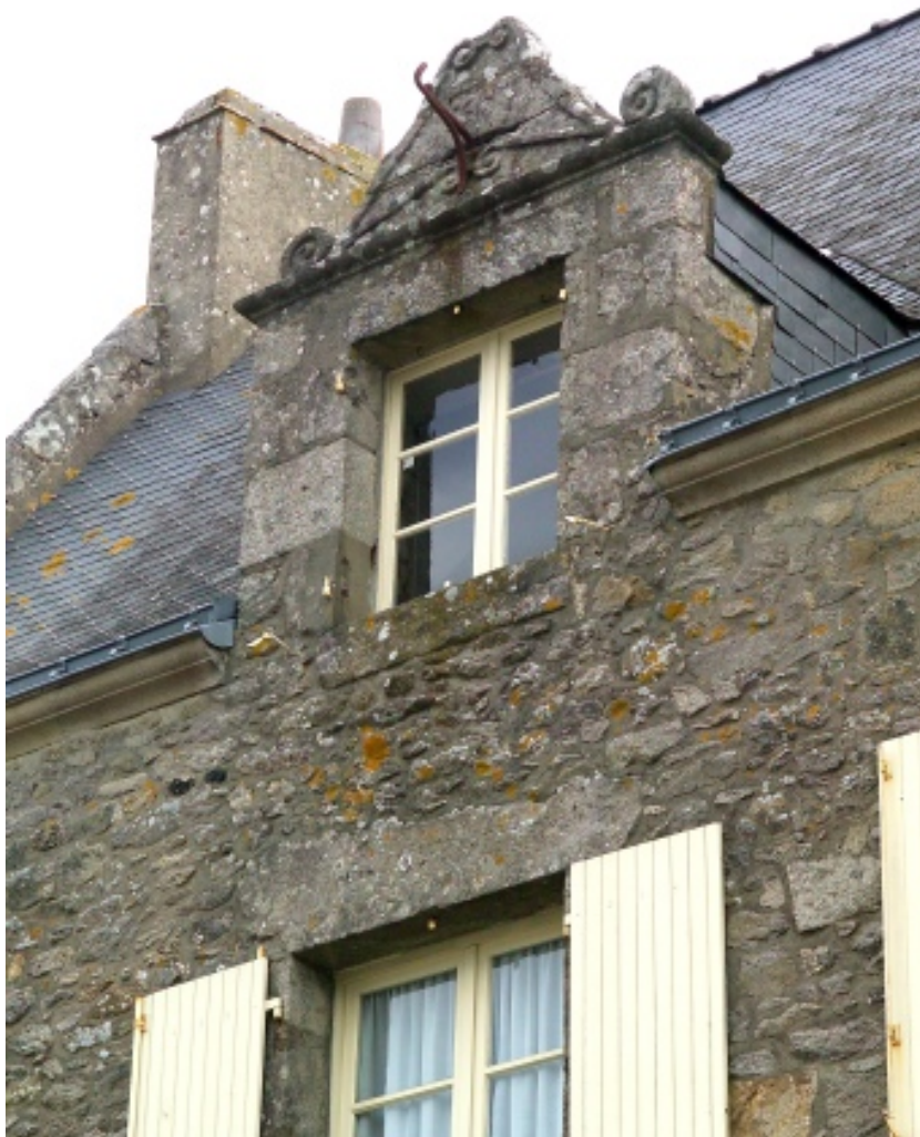
Détail de lucarne sur la façade, au Nord.
