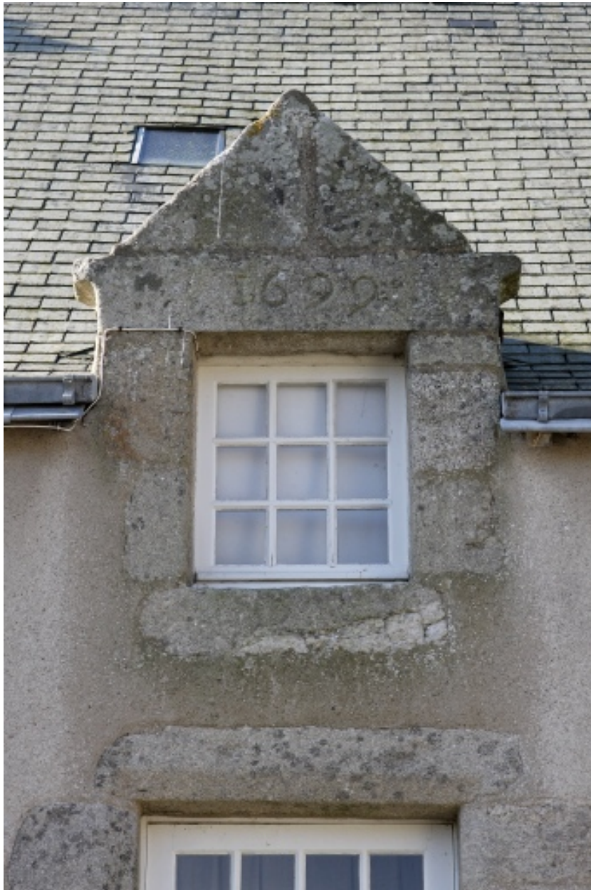
Détail de la lucarne datée 1699 du logement est.
