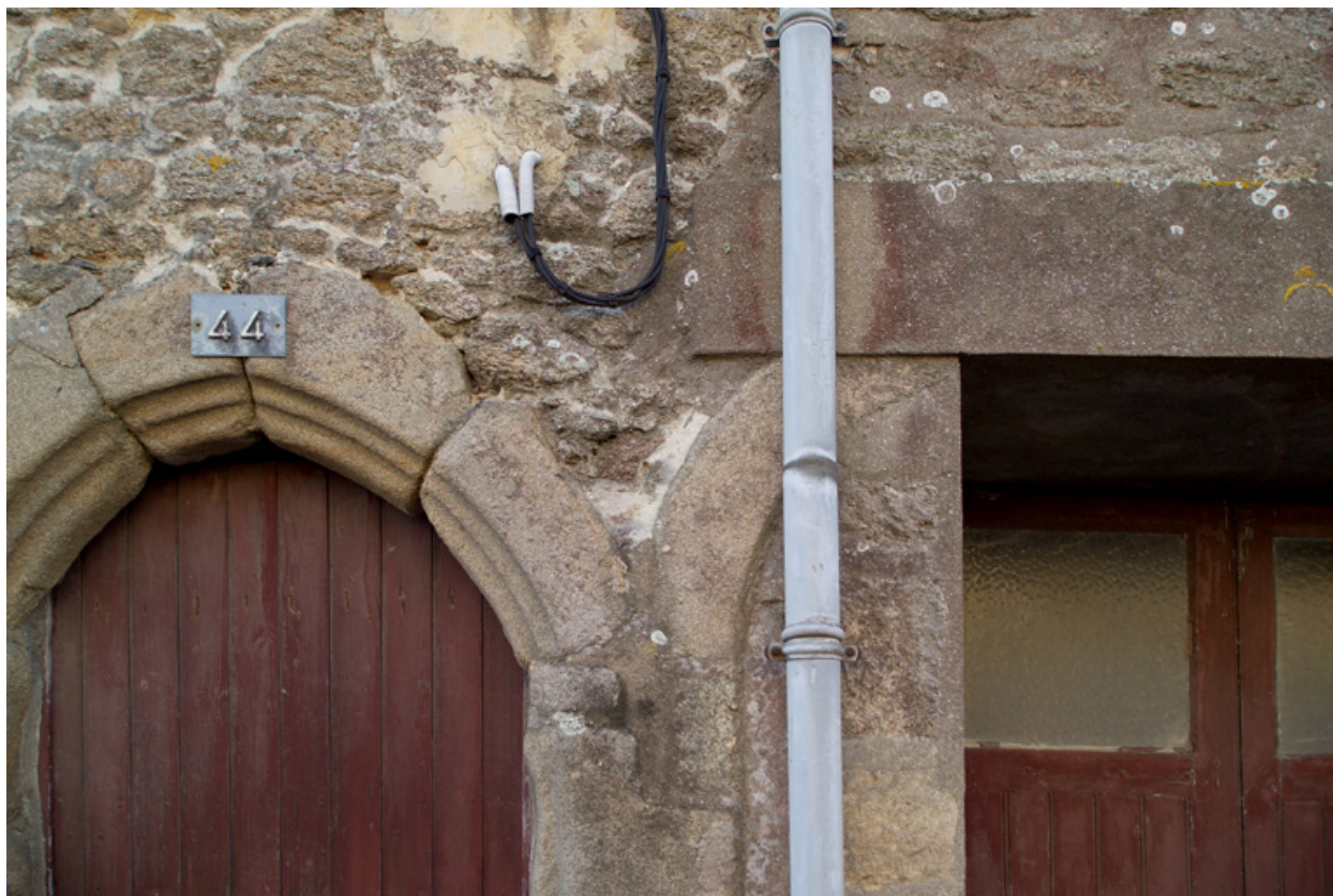
Corps principal, façade nord, détail des arcs de porte.
