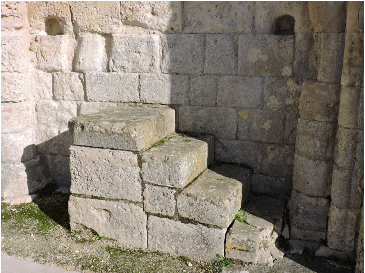
Arcature sud : degré (chaire à prêcher ?).
