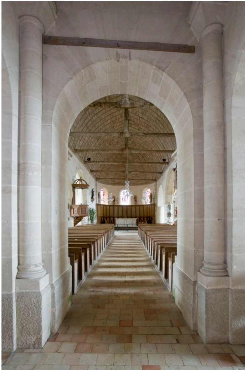
Vue intérieure depuis le rez-de-chaussée de la tour
