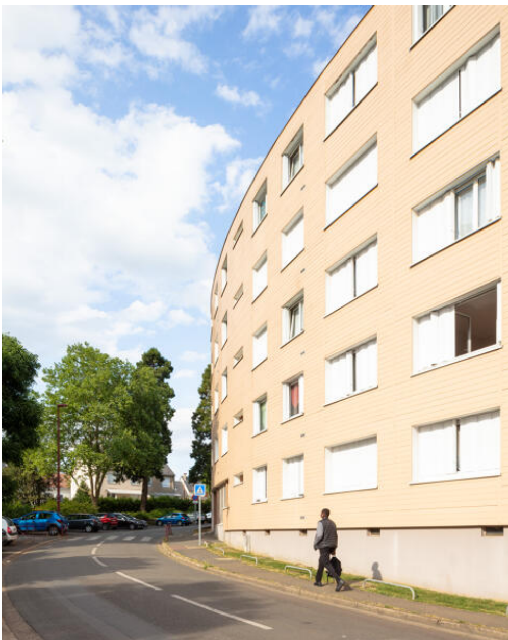
Vue de la façade rue Henri Bersgon depuis le sud.
