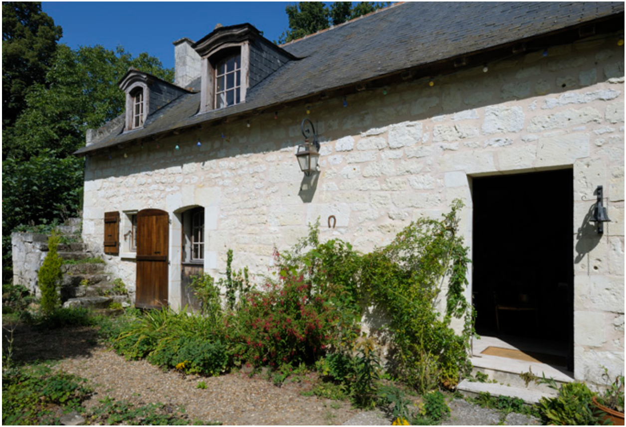
Aile ouest (fin XVIIe ou début XVIIIe siècle). La maison, à gauche, et l'ancienne étable (remaniée) à droite.
