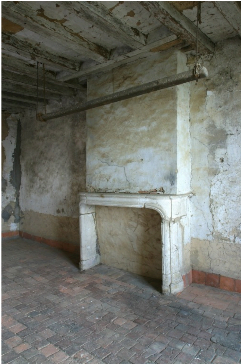
Rez-de-chaussée surélevé. Pièce 2B : la cheminée, située contre le mur nord.
