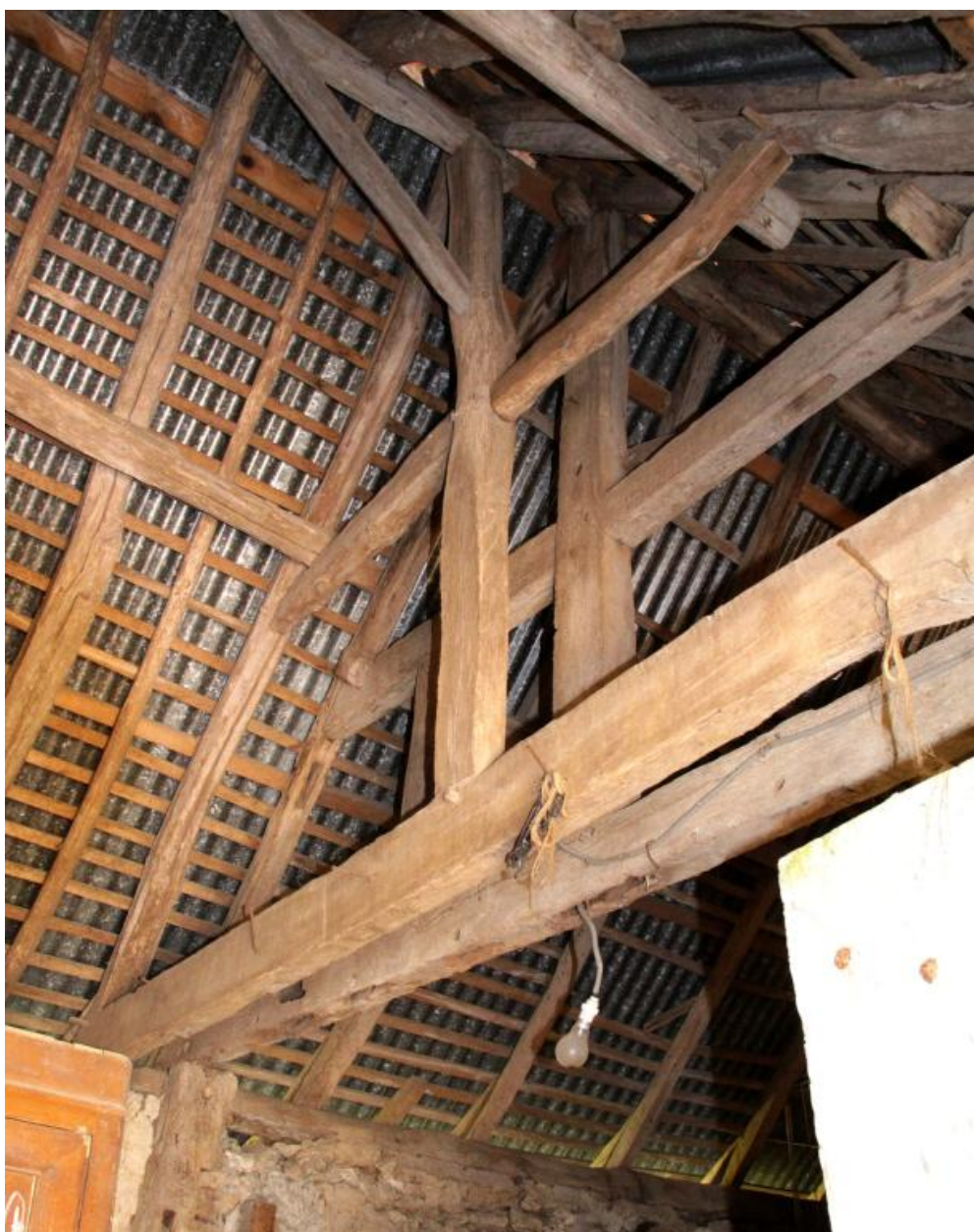
Etables et buanderie : détail de la charpente.
