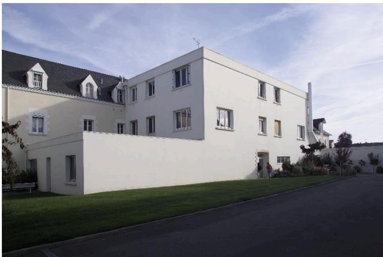
La façade sud, le corps central.
