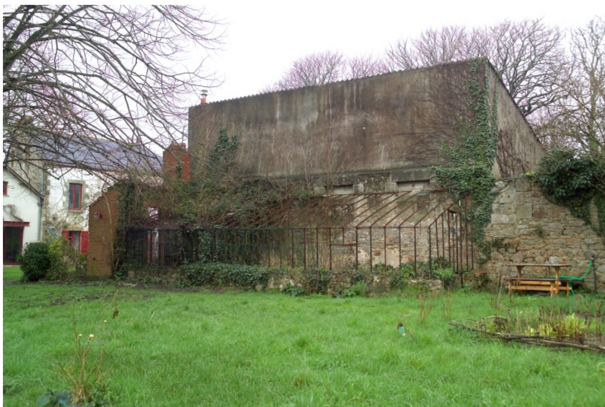
Vue de la serre vers le Nord.
