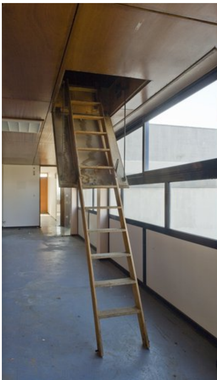
Echelle donnant accès au dernier niveau.
