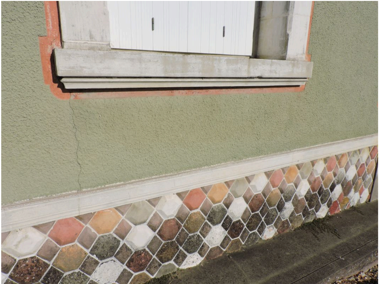
Détail du décor de la façade : enduit, encadrement et appui de baie, solin en parement.
