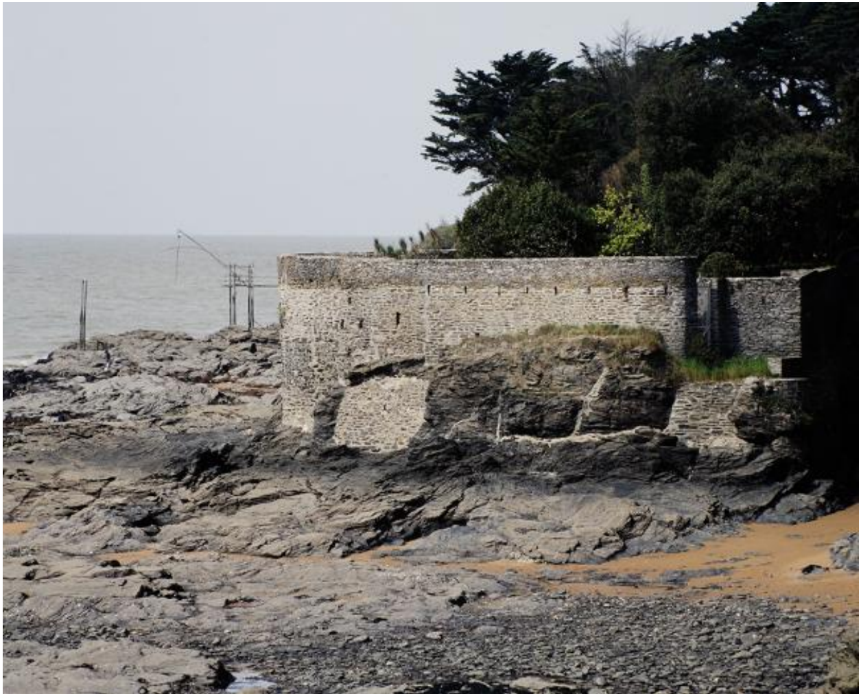
Mur de soutènement sur la côte.
