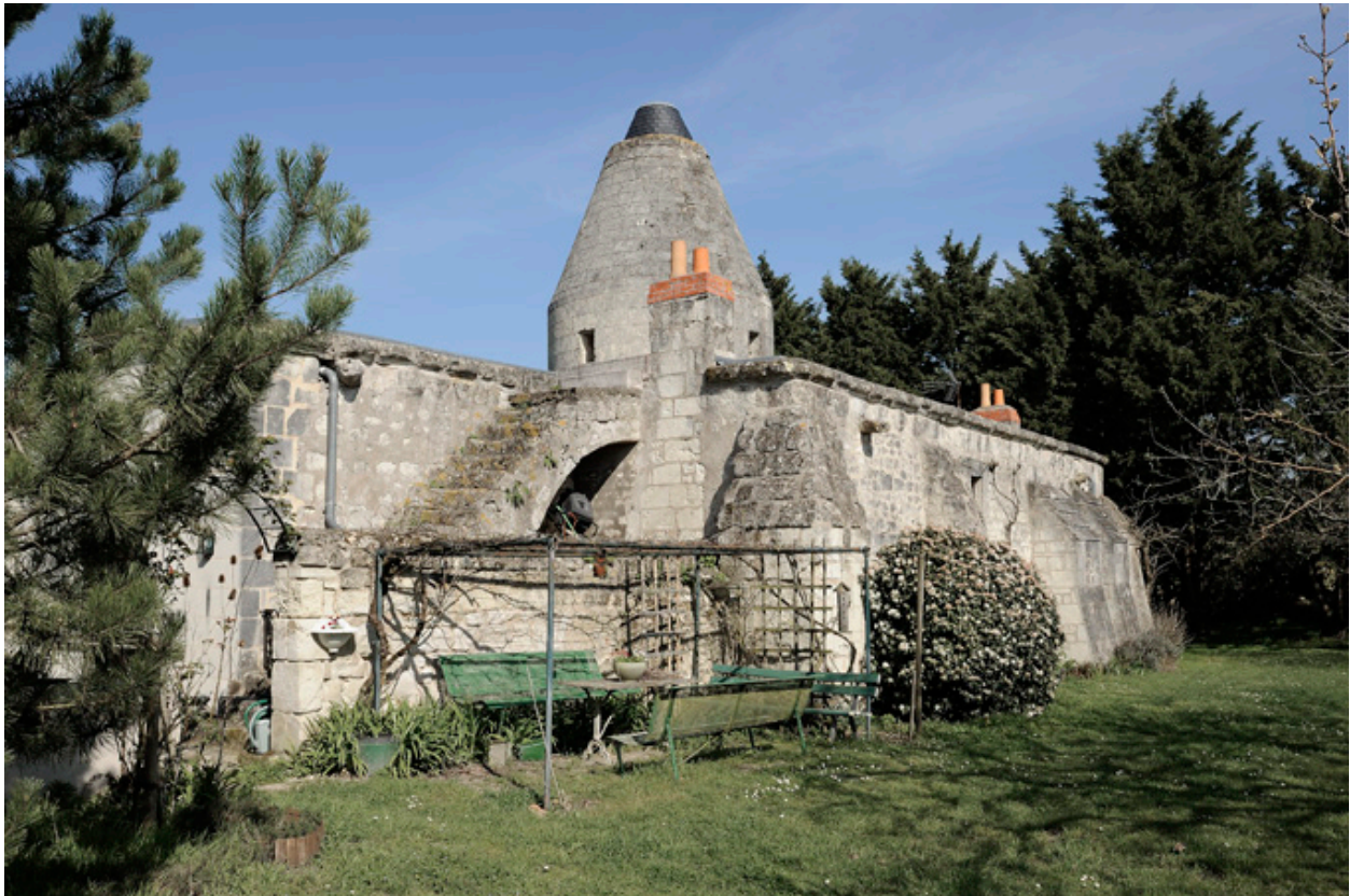
Moulin Neuf : façade sud
