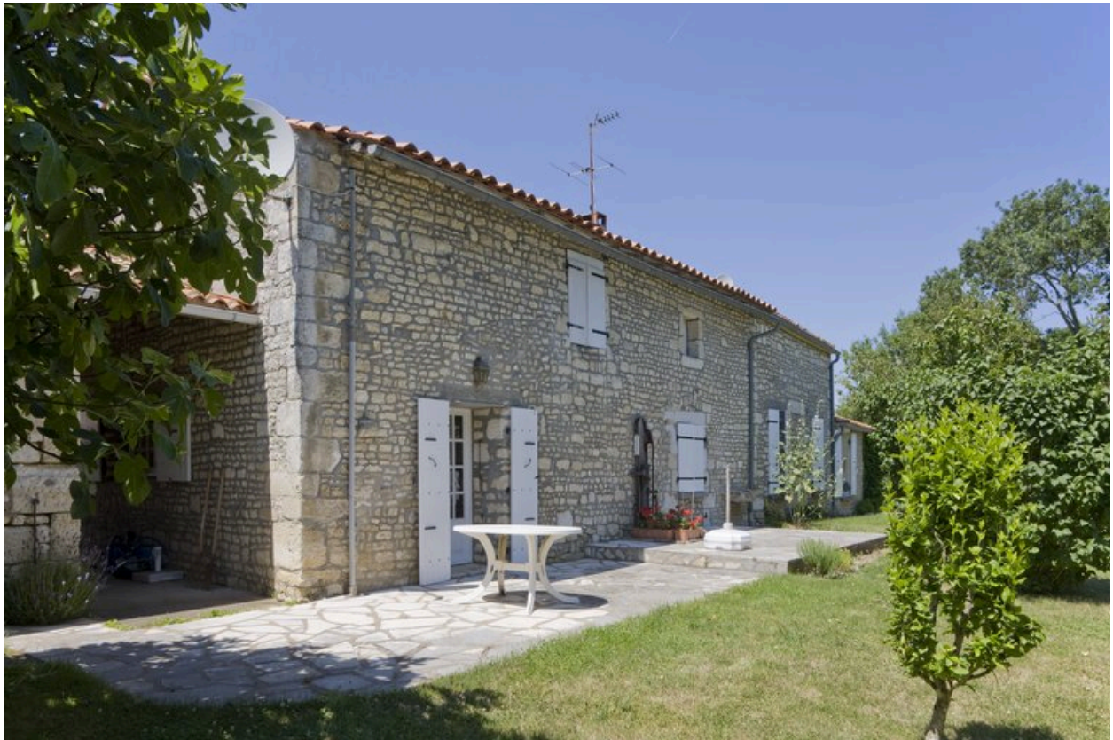
Façade est de la maison.
