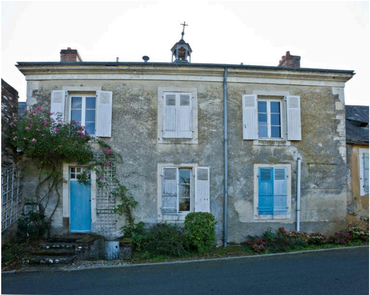
Façade (nord) sur rue.
