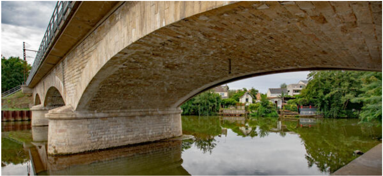
Vue du tablier et des piles du pont de Tours.
