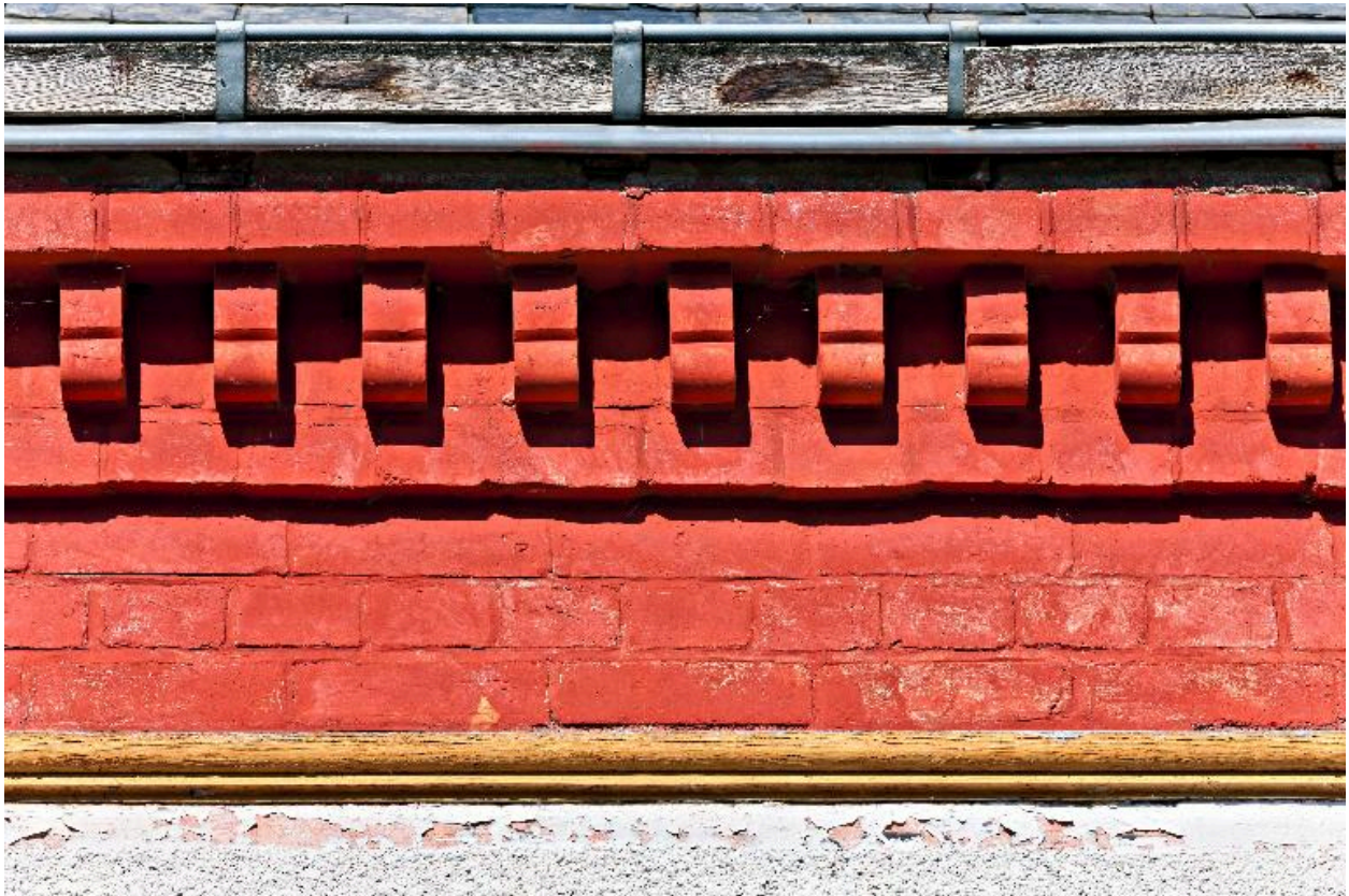
30, rue Basse. Détail de la corniche en briques peintes.
