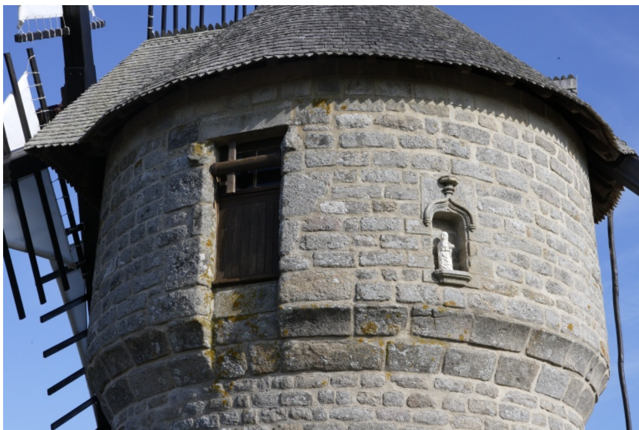
Détail de la cage, côté ouest.
