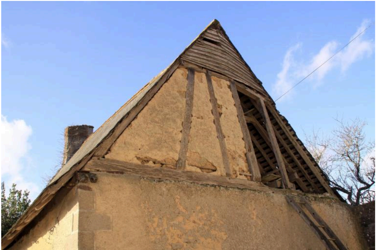
Grange-étable, pignon, détail : pan de bois.
