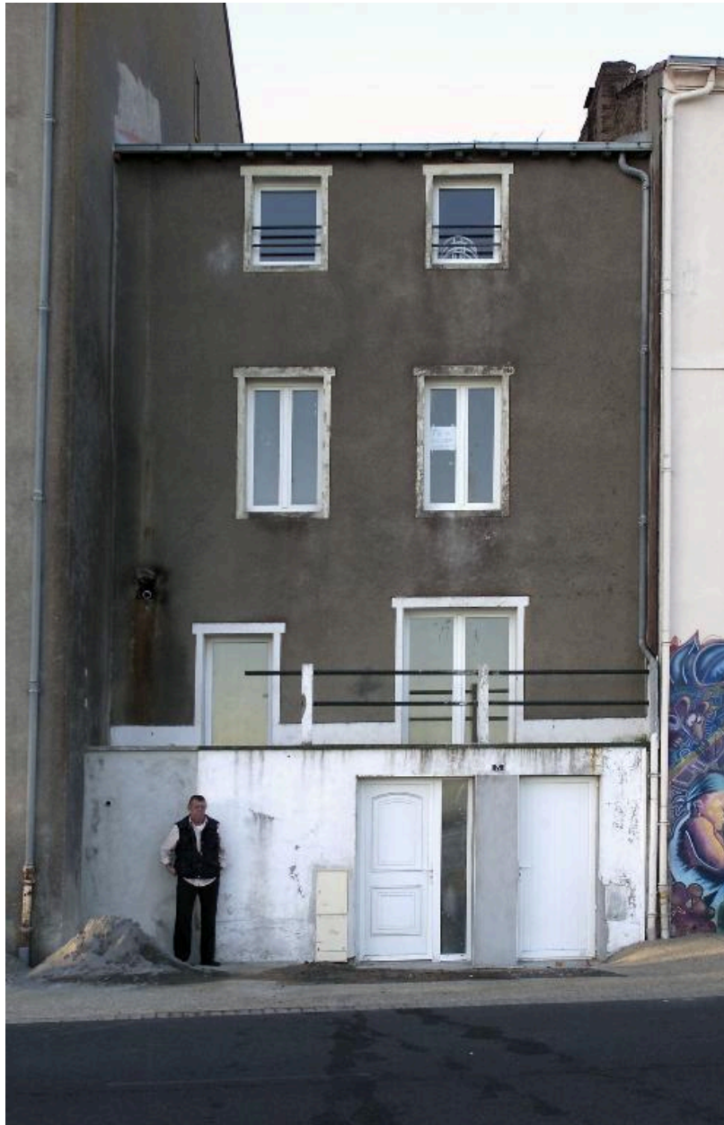
La façade vue depuis le quai.
