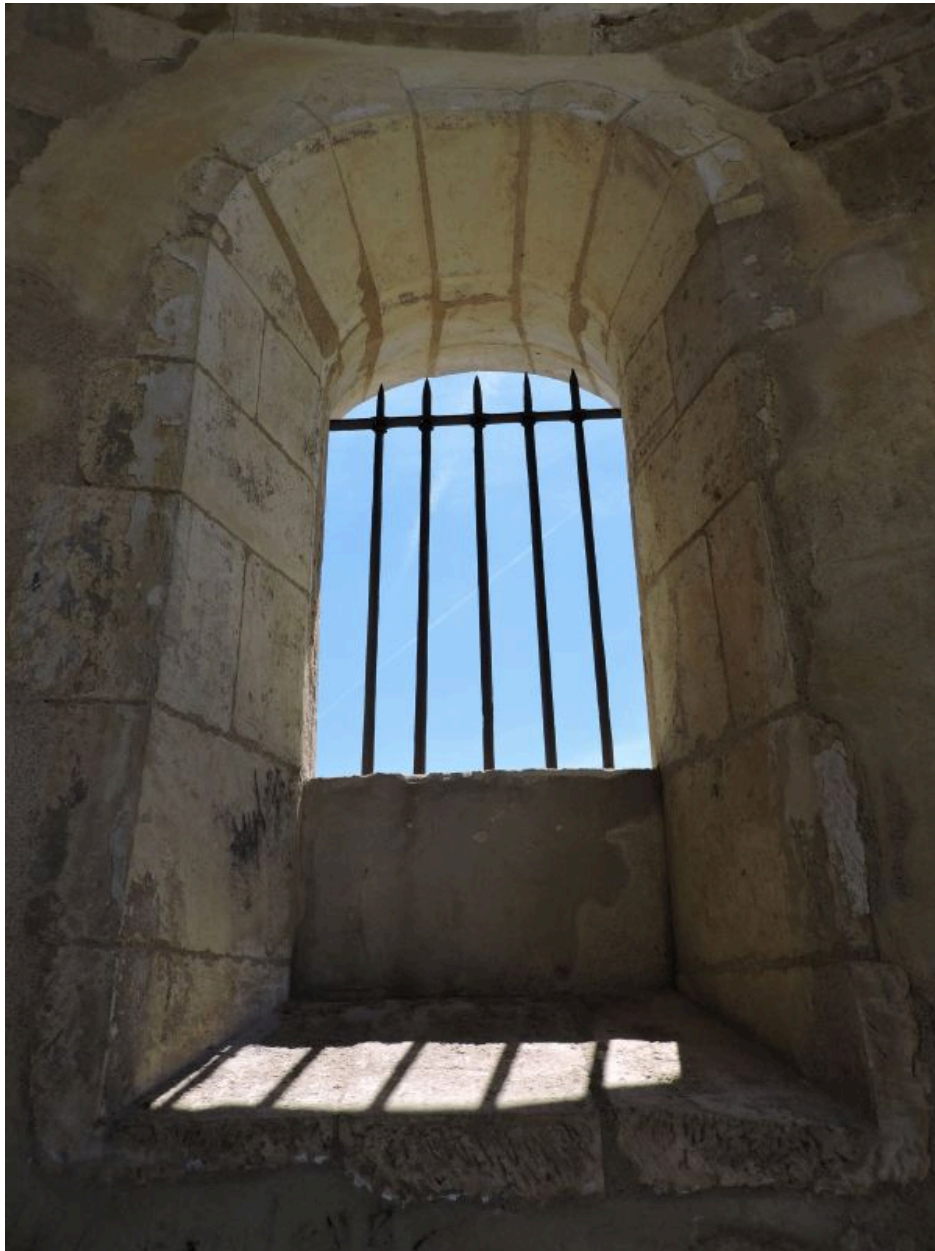
La baie sud de l'abside vue depuis l'intérieur.
