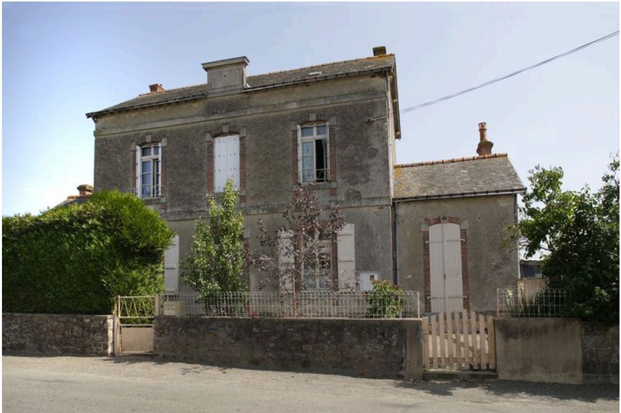
Le logement et l'ancienne mairie vus depuis la rue au nord.
