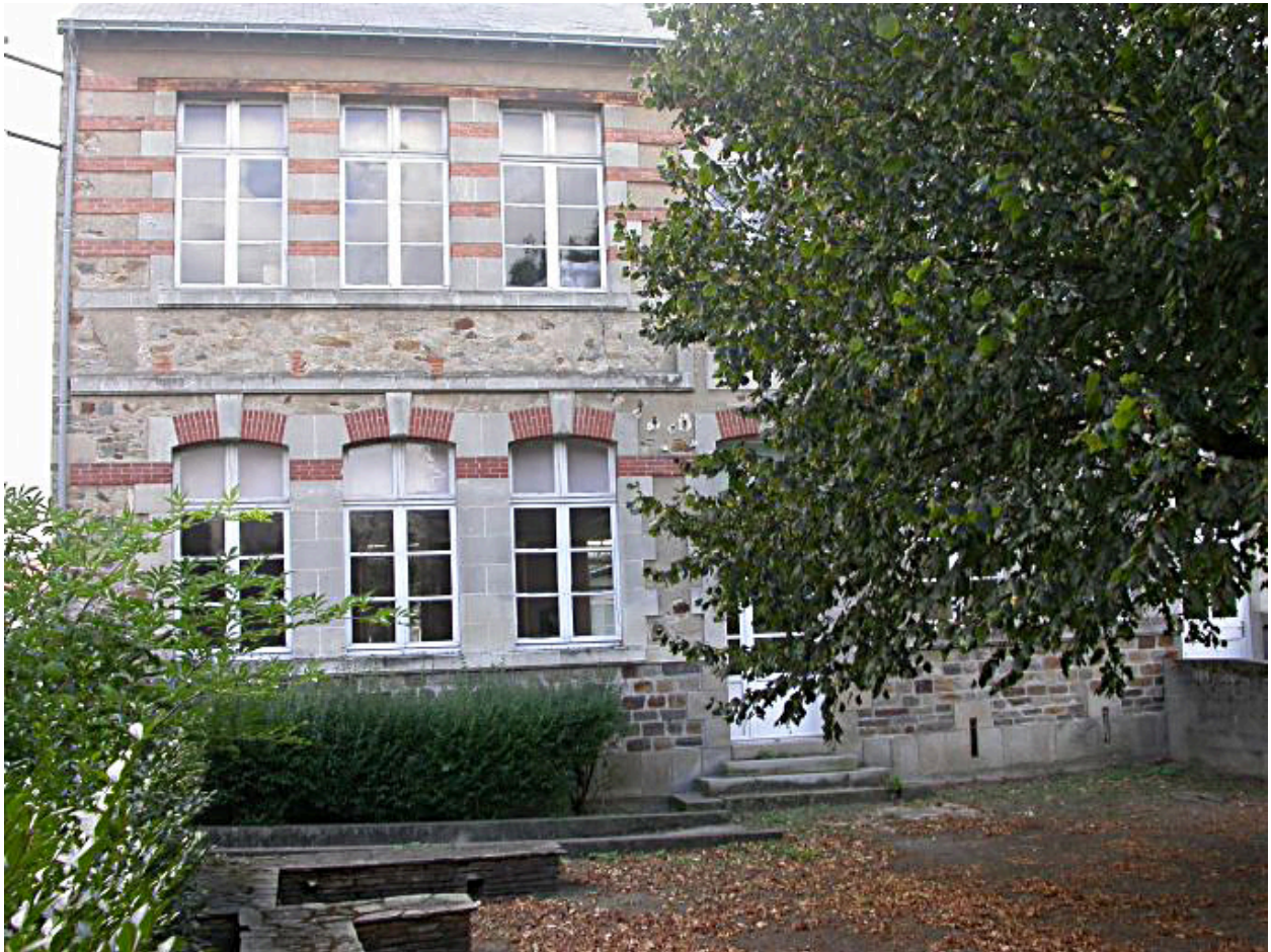
Vue partielle de l'école primaire depuis la cour nord.
