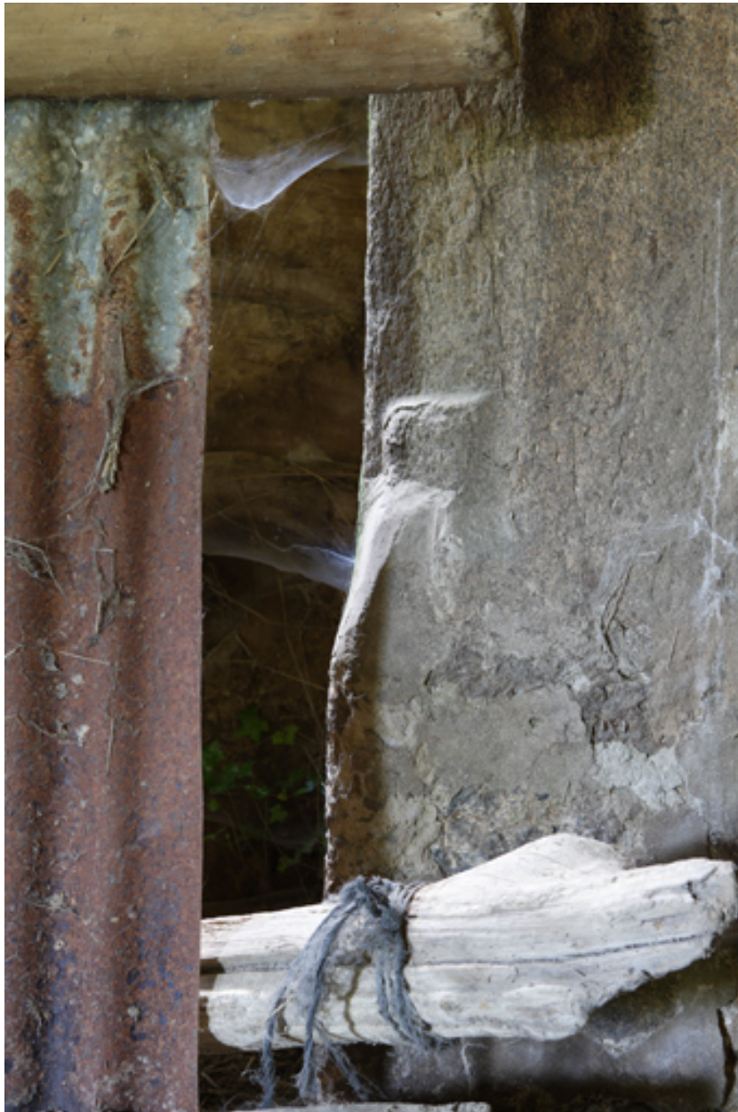
Bâtiment est. Métairie (?). Détail du congé à la base de la cheminée.
