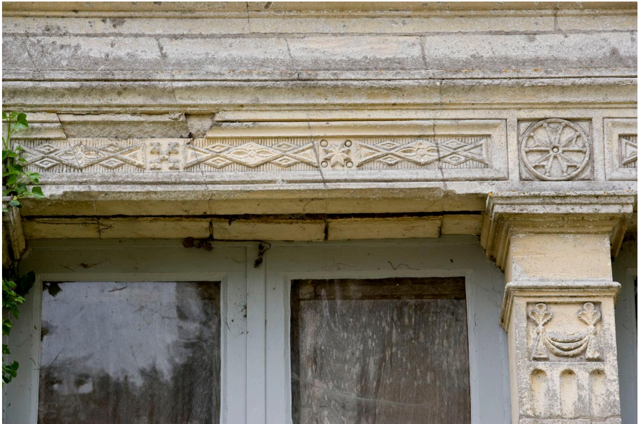
Détail de la fenêtre nord de l'aile ouest.
