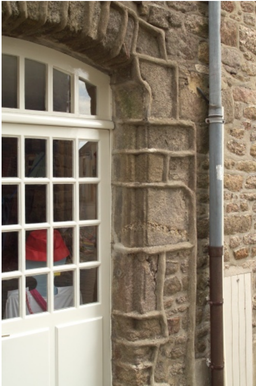
Détail du montant sud de la baie sud-ouest du pignon ouest.
